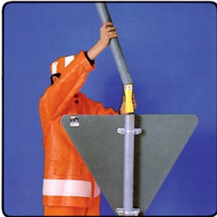
▲ long-fix und Verlängerungsrohr zusammen locker von Hand einsetzen und ...
